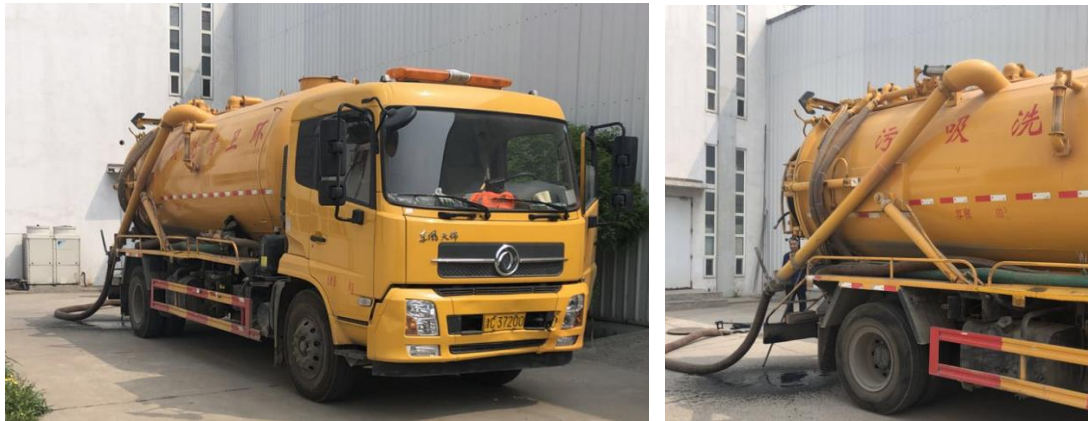
图 4-3 化粪池清掏现场
