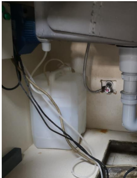
图 4-1 项目污水处理设备图
