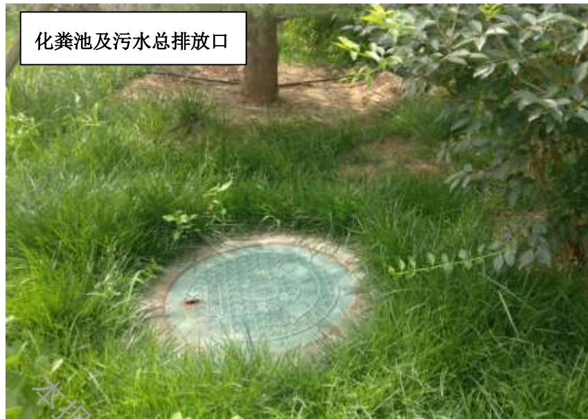
图 4-2 项目污水处理设备图
